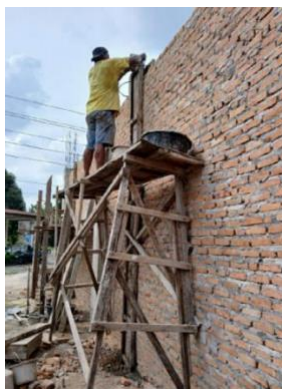
Gambar 2. Kondisi penambahan kolom praktis
