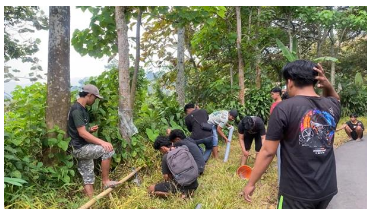
Gambar 4. Pemasangan Tiang Reflektor Bersama Tim KKM Universitas Darul Ulum dan Karang Taruna Dusun Segunung
