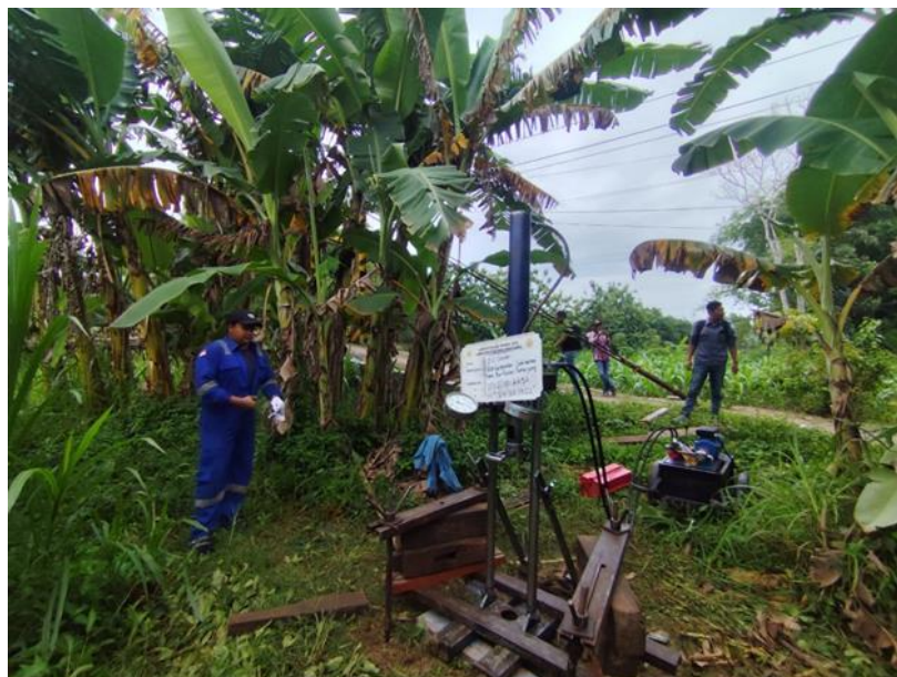
Gambar 2. Pelaksanaan pendampingan uji sondir/CPT menggunakan CPT hidraulik
