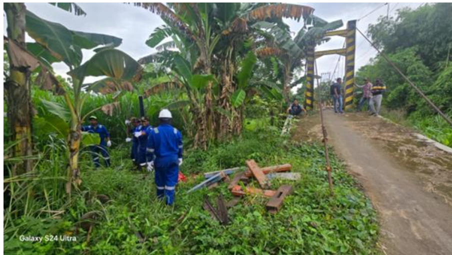
Gambar 1. Kondisi di lapangan akses dan lokasi jembatan Desa Buntalan saat survei/persiapan kegiatan
