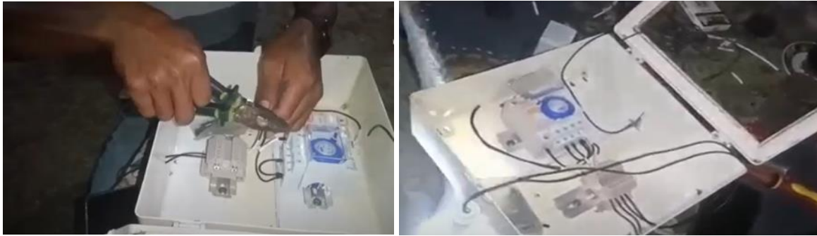
Gambar 4. Perakitan panel kontrol
