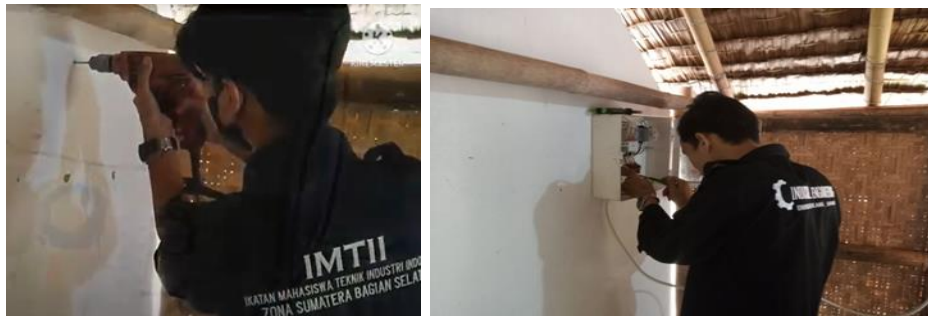
Gambar 5. Pemasangan panel kontrol di lokasi
