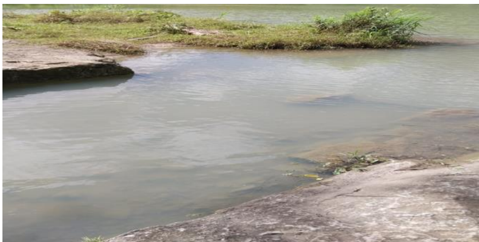
Gambar 6. Kerusakan pada Situ Cidanti
